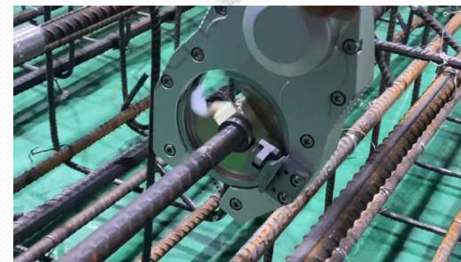
柱鋼筋骨架連接快速安裝
