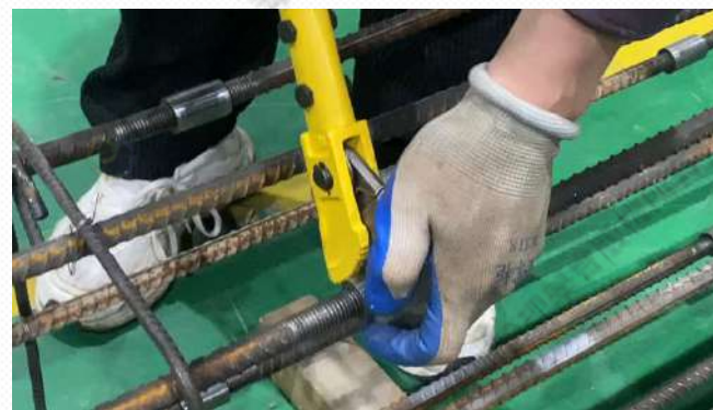
柱鋼筋骨架連接安裝
