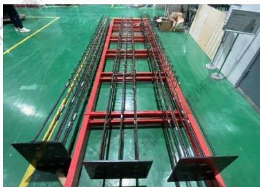
柱鋼筋骨架連接安裝成品
