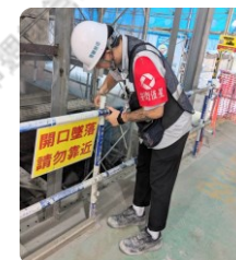
欄杆每日巡檢
